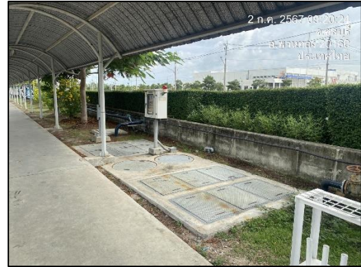
ภาพที่ 12 จุดระบายน้ำเสียเข้าสู่ระบบบำบัดน้ำเสียของนิคมฯ
