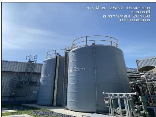
ภาพที่ 15 ถังพักน้ำทิ้งฉุกเฉิน
