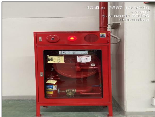
ภาพที่ 35 ตู้สายฉีดน้ำดับเพลิง
