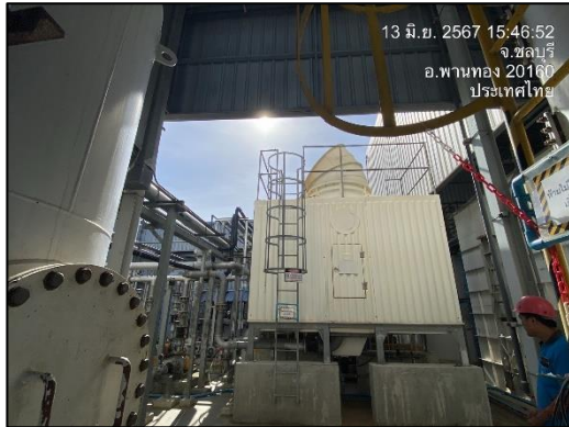
ภาพที่ 18 ระบบน้ำหล่อเย็น
